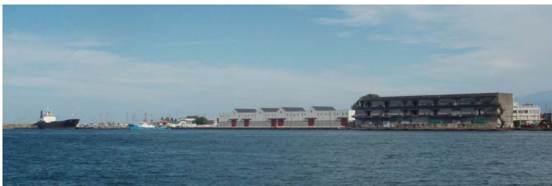
対岸より富山港1号上屋を望む
